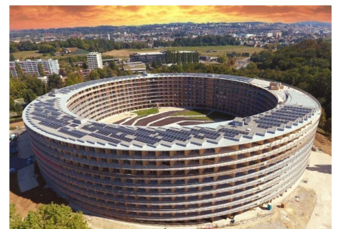
Il a fallu 29 mois pour construire le Vortex. Photo: Groupe CBS-Lifteam - facebook
