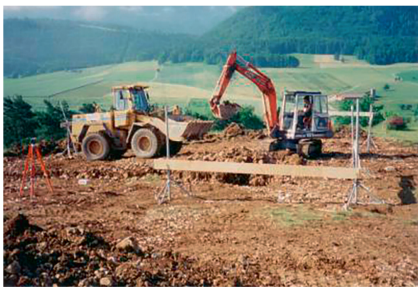
Début des travaux, 1 er juin 1993.
