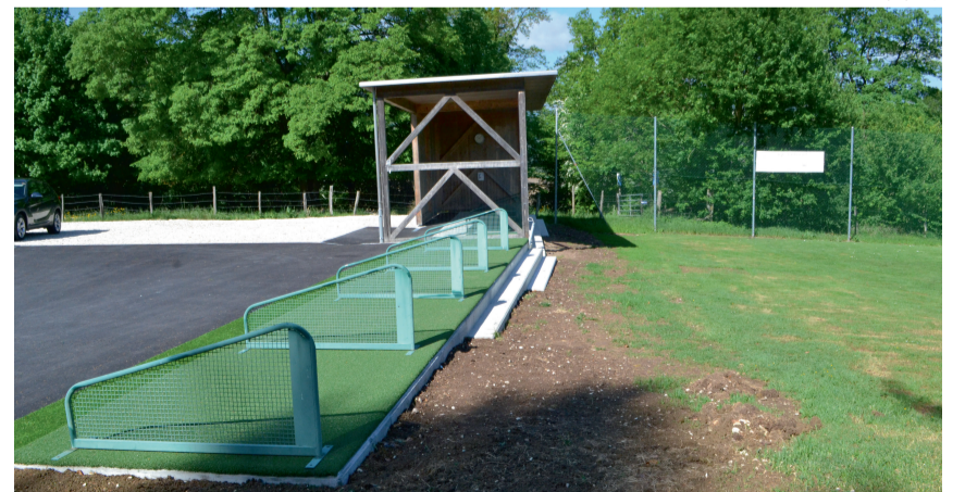
Pour marquer les 25 ans du club, le comité a décidé de stabiliser toutes les places d'entraînement sur une dalle en béton.
