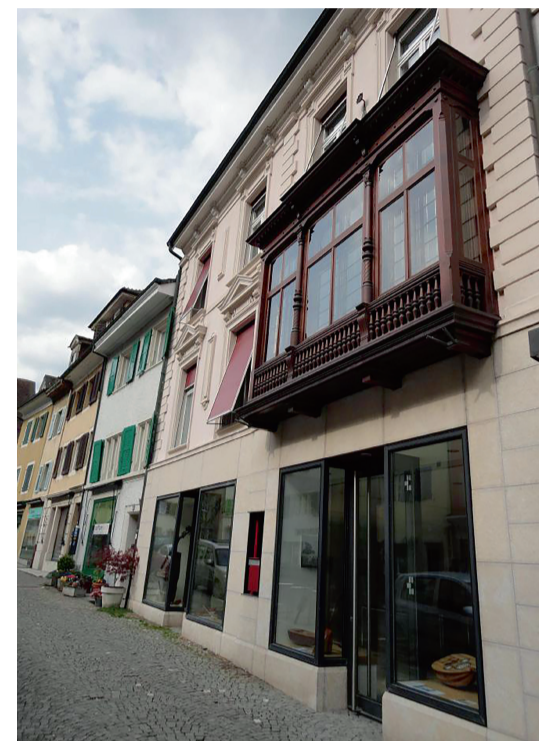
Bâtiment de la FARB - Façade de la maison de la Fondation FARB, côté rue de Fer, à Delémont.
