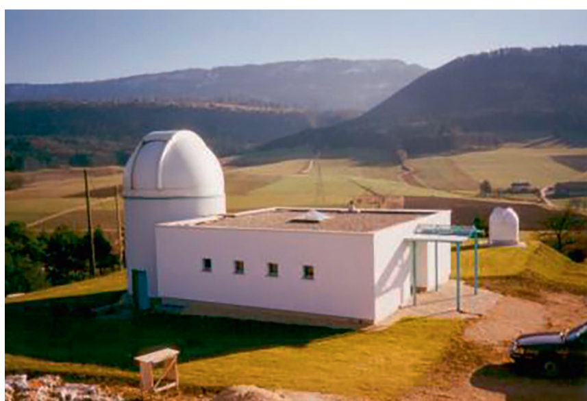
Fin de la construction de l'observatoire de Vicques.
