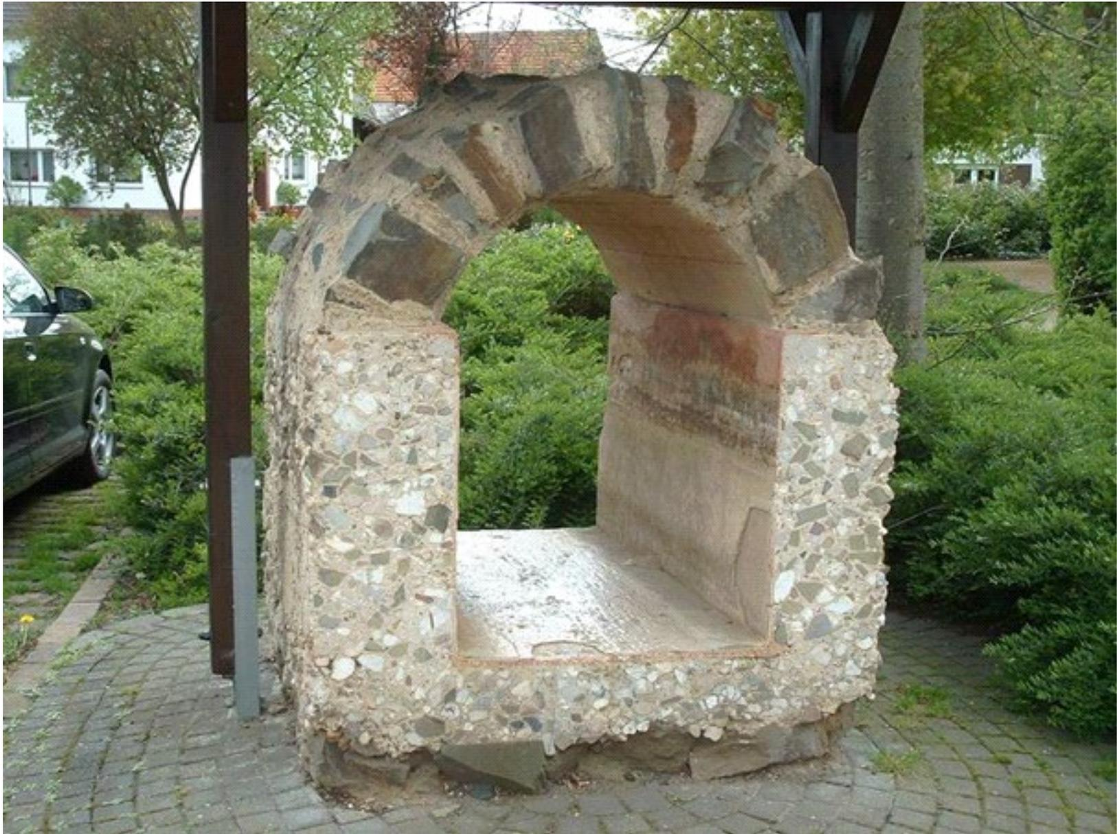
Détails de la construction de l'aqueduc de l'Eifel (Allemagne)
